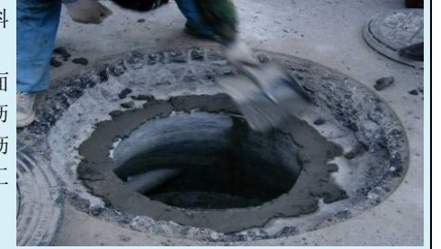
图8 井口水泥砂浆找
