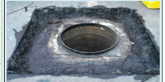
图9 铸铁调节环安装
