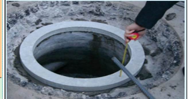
图9 预制砼调节环安装
