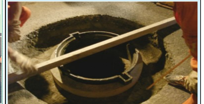
图9 限位井圈安装
