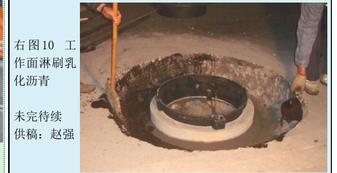
图9 限位井圈安装
